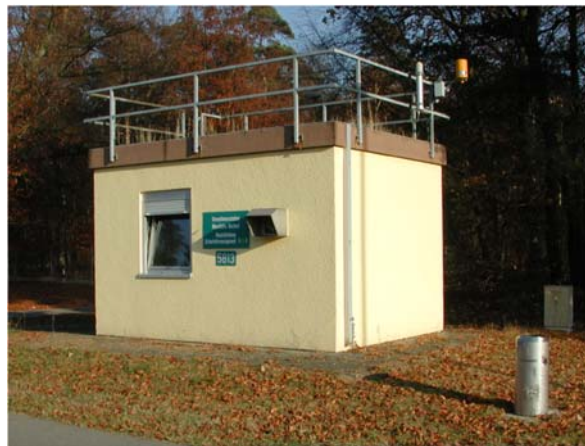
Messhütte Umgebungsüberwachung B 5813
