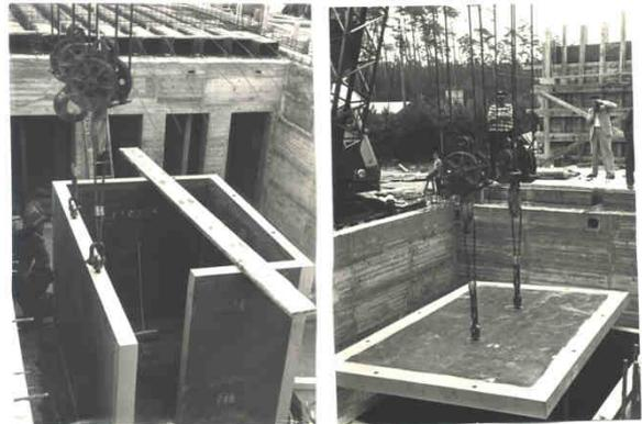
Aufbau der Abschirmkammer aus Stahlplatten
