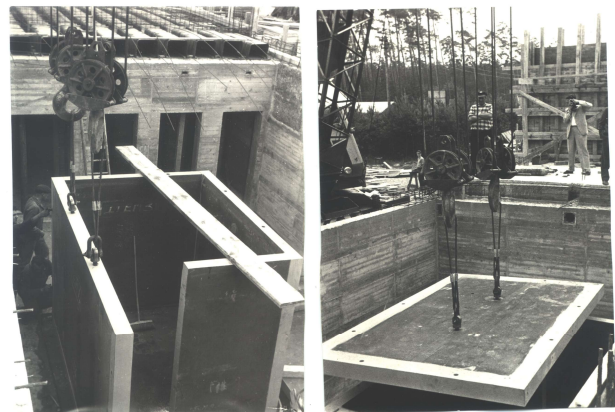
Aufbau der Abschirmkammer aus Stahlplatten
