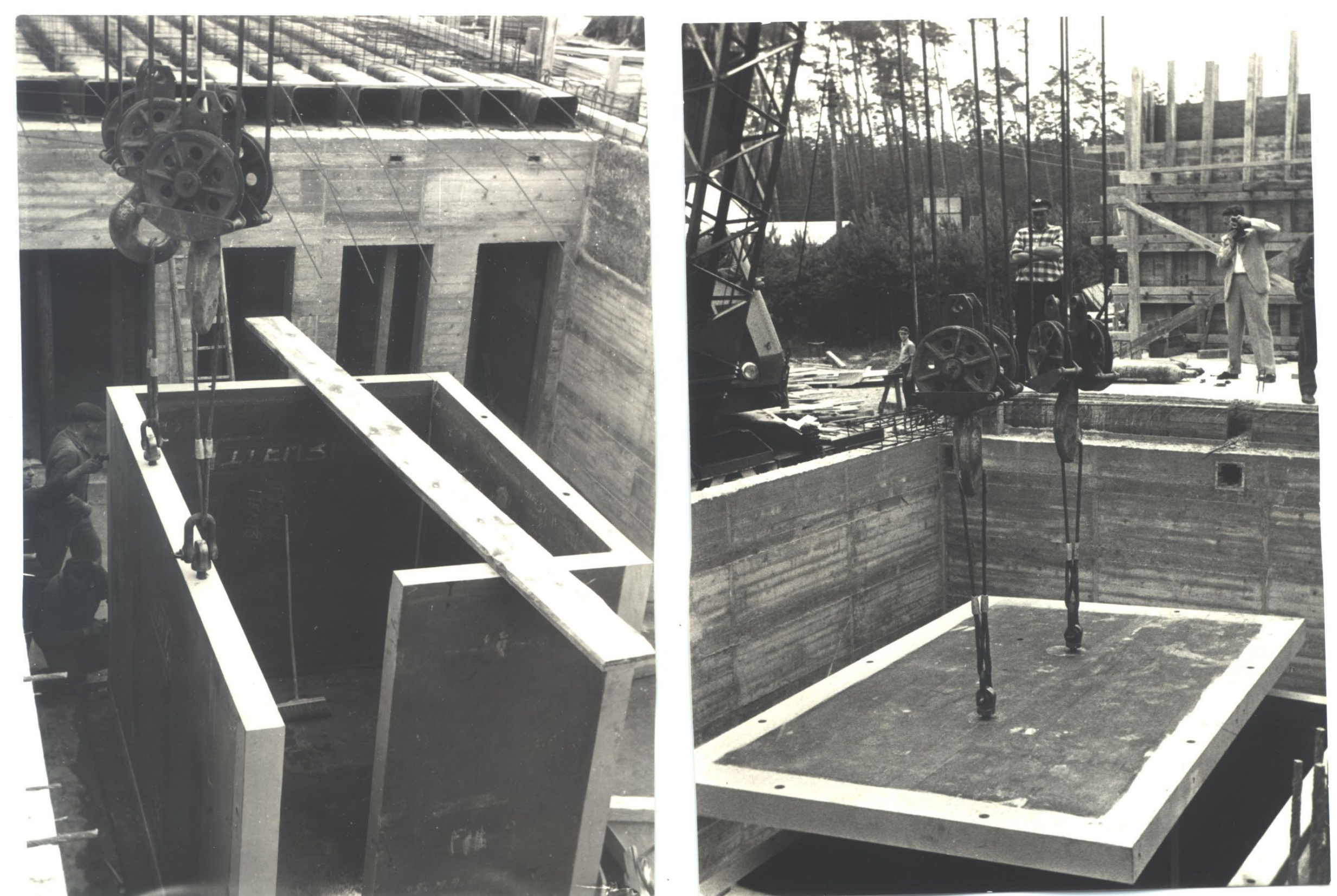
Aufbau der Abschirmkammer aus Stahlplatten
